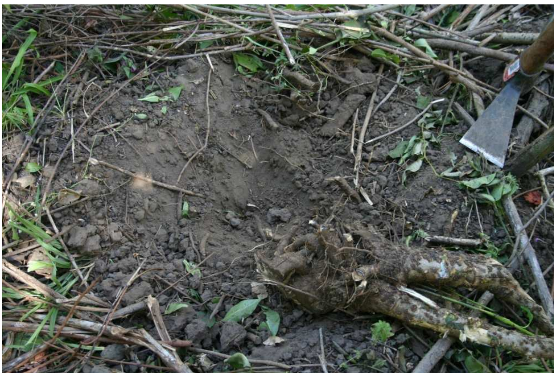
Figura 15 - Tratamento com destoca sendo aplicado.
