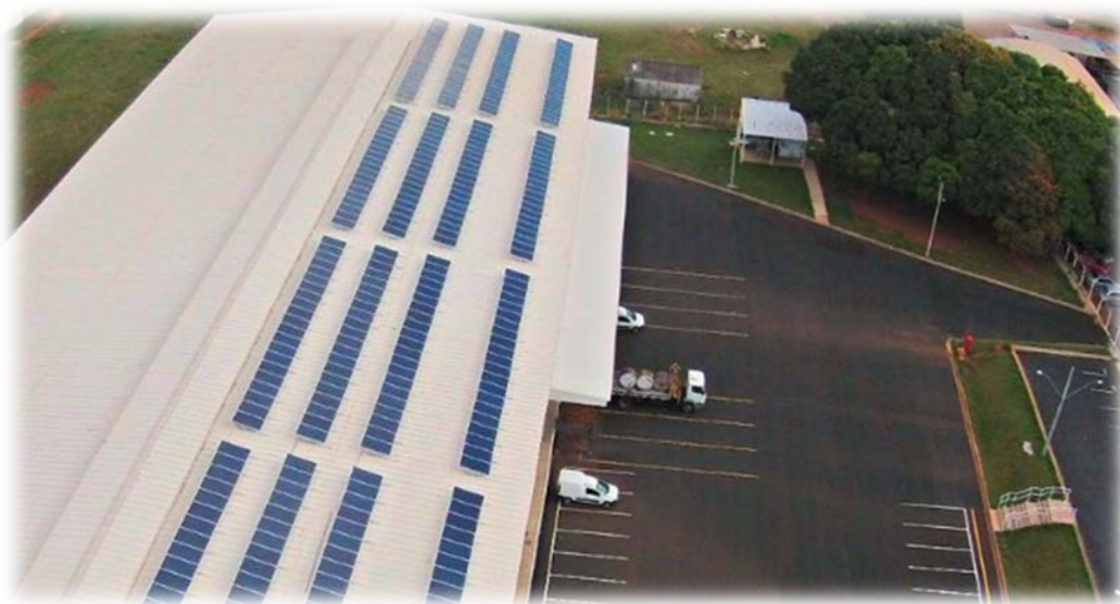
Galpão – 75 kWp - Alsol
