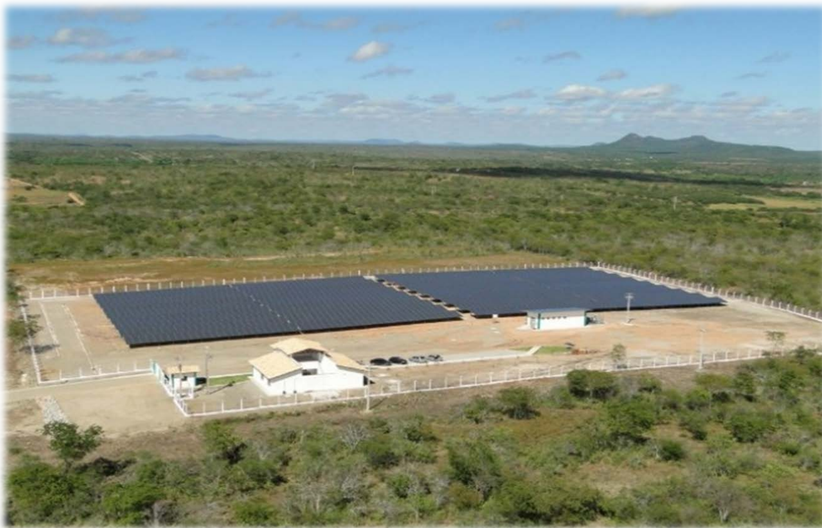
Usina fotovoltaica construída em Tauá/CE – 1 MWp - 2011
