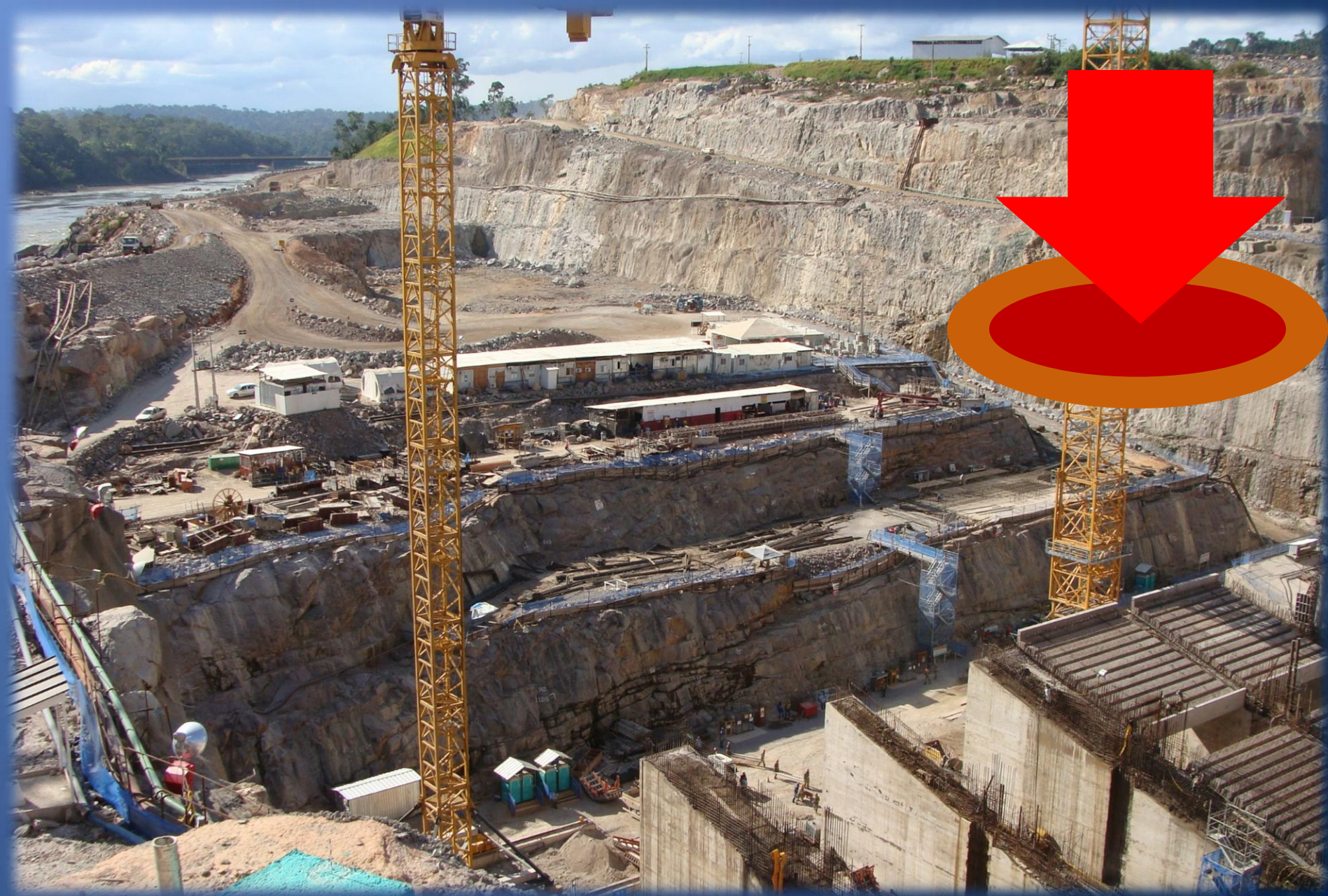
Canteiro de obras da Usina Teles Pires (MT-PA). Foto: Andrey Schlee
