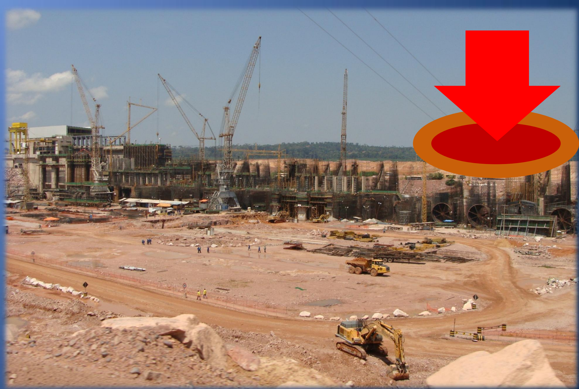
Canteiro de obras da Usina Hidrelétrica de Jirau (RO). Foto: Andrey Schlee
