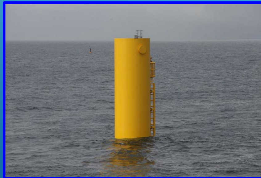
BASE DA TORRE JÁ LANÇADA
