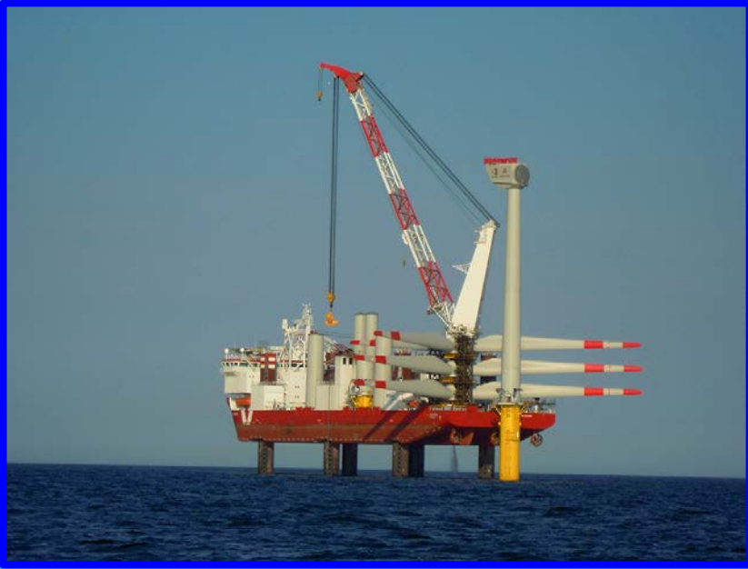
BALSA DE LANÇAMENTO “ JACK UP BARGE ”
