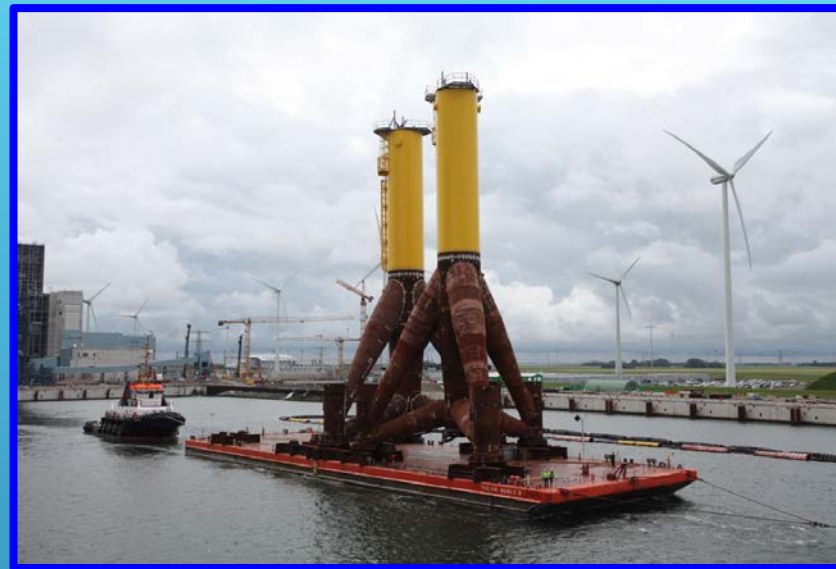
TRANSPORTE EM BALSAS DE SERVIÇO
