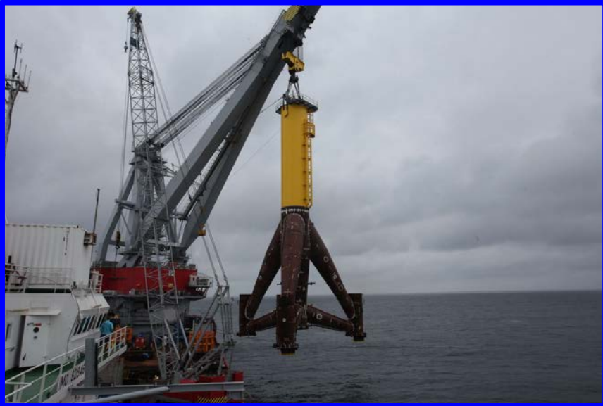
LANÇAMENTO COM BALSA GUINDASTE
