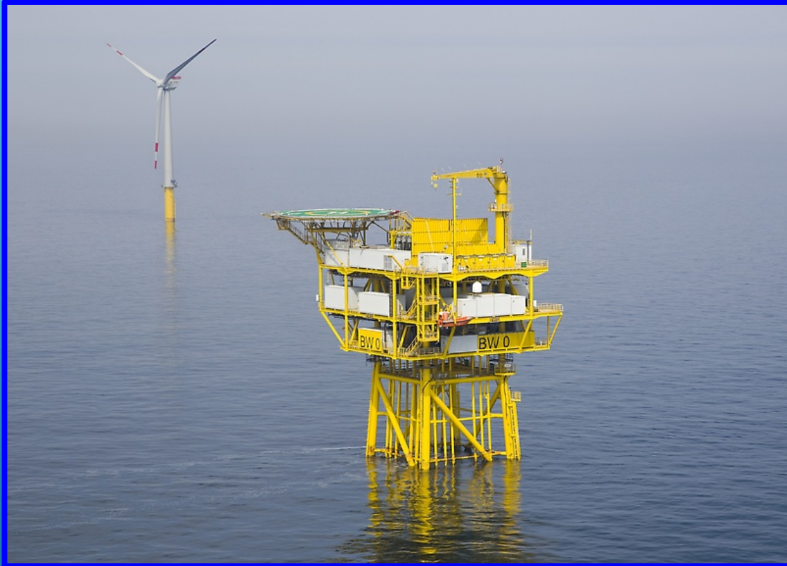
PLATAFORMA DE CONTROLE E ALOJAMENTOS BORKUM WEST II - MAR DO NORTE
