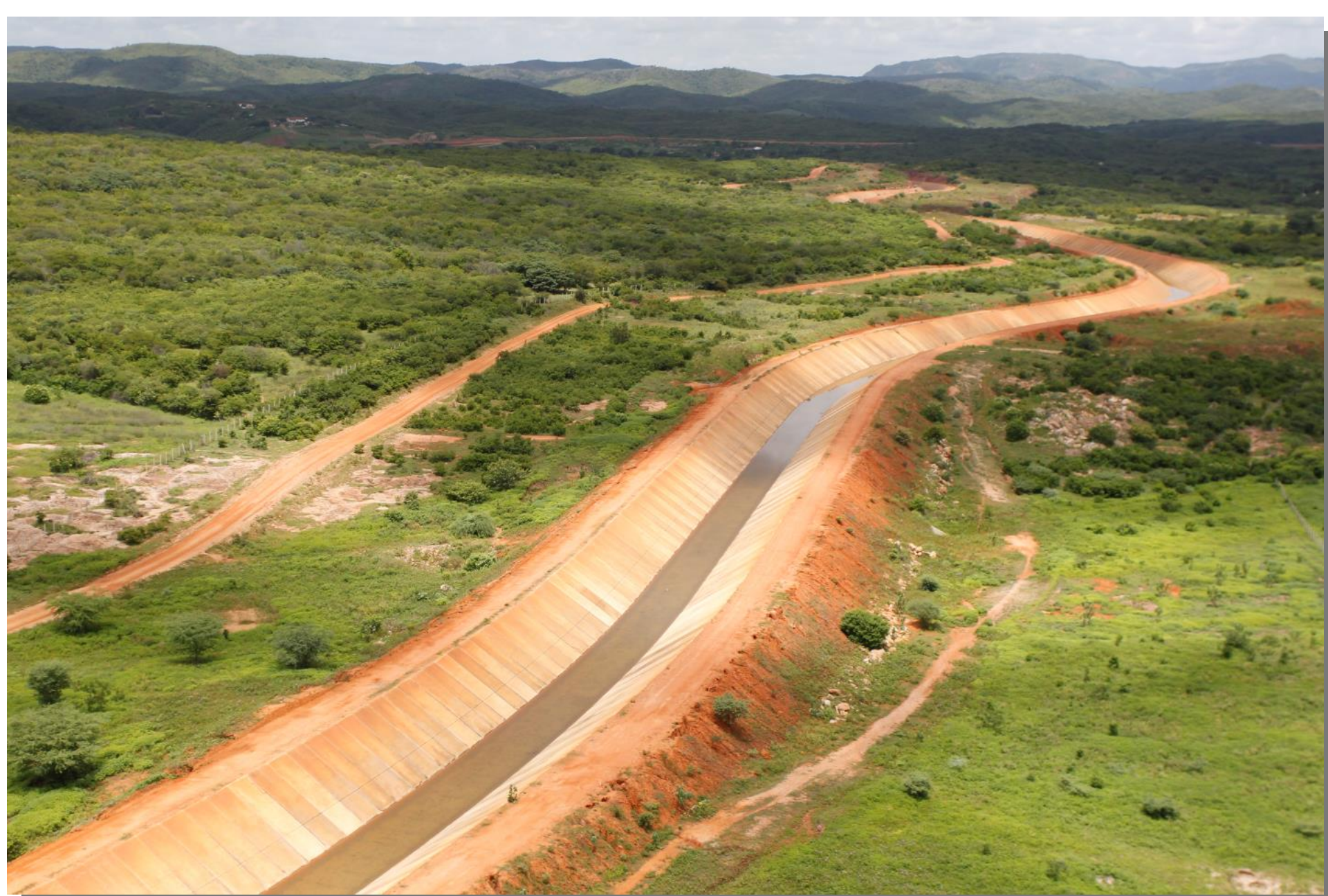
Canal anterior ao Túnel Cuncas I
