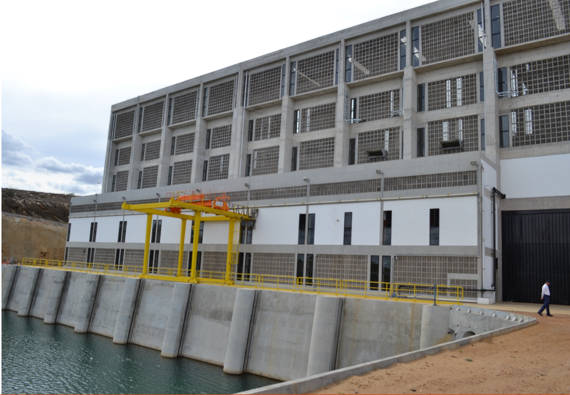
Forebay 1 da EBI 1
