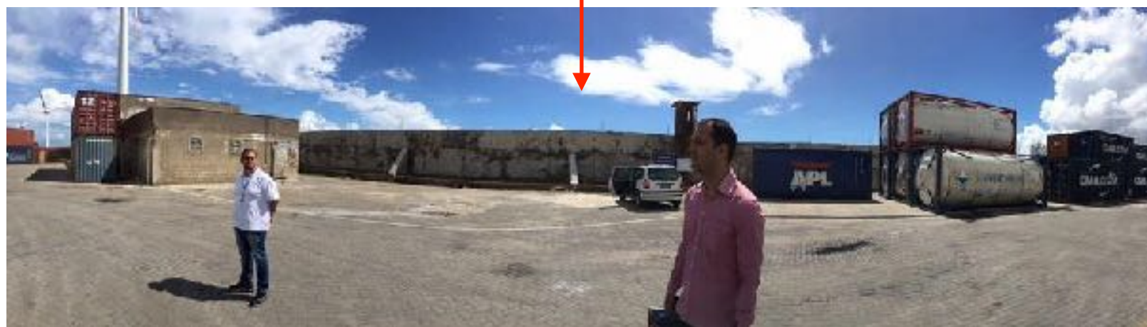
Vista interna (Pátio do Porto do Mucuripe) do muro que precisa ser removido
