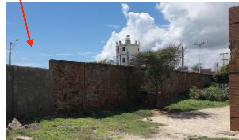
Vista interna (Corpo de Bombeiros) do muro que precisa ser removido
