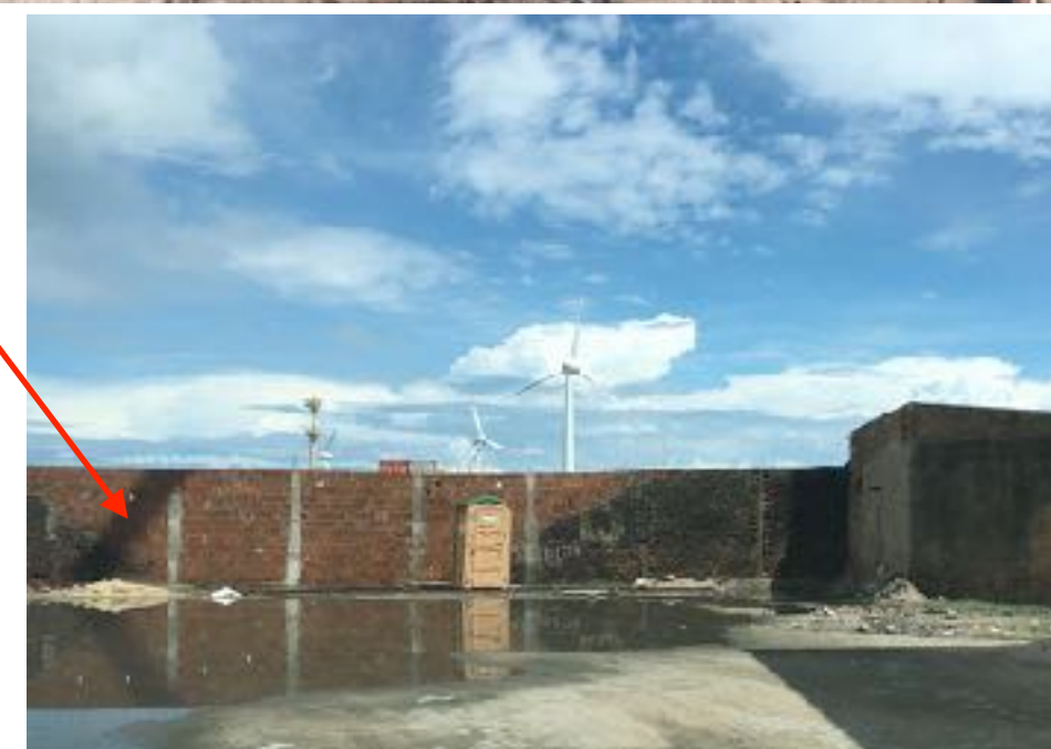
Vista do segundo muro que pode ser removido para construção de uma via de mão dupla
