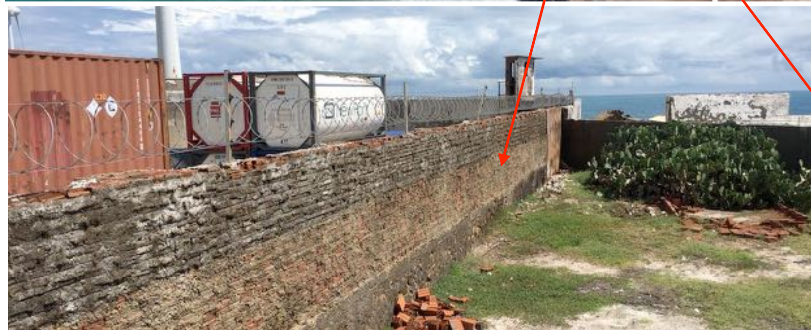
Vista do primeiro muro que pode ser removido para construção de uma via de mão dupla
